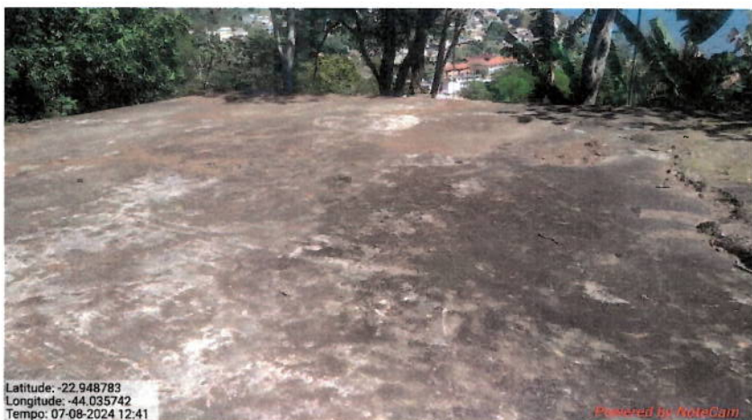
Foto 18 – Parte superior do reservatório R1.
