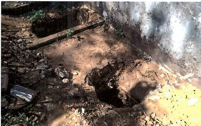
Foto 17 – escavações realizadas para verificação de vazamento do reservatório.
