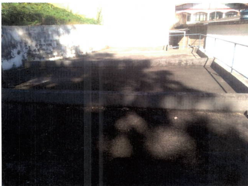
Foto 22 – Parte superior do reservatório R2.
