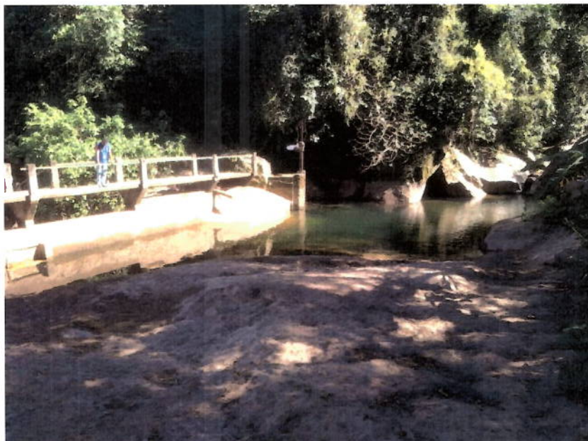
Foto 6- Barragem da Serra do Piloto.
