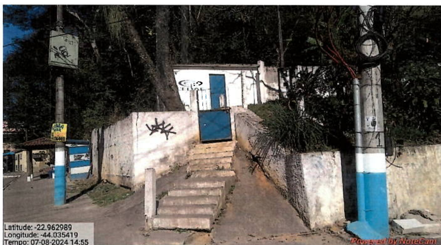
Foto 27 – acesso ao Reservatório R3.
