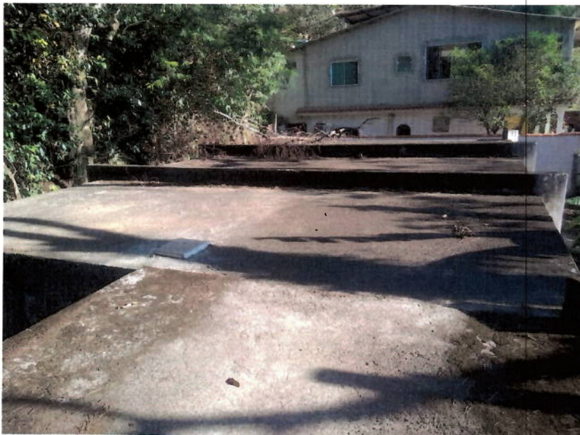
Foto 28 – Parte superior do Reservatório R3.
