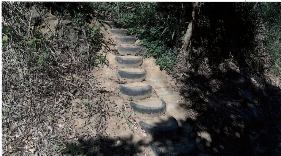
Foto 16 – escada de acesso ao Reservatório R1.
